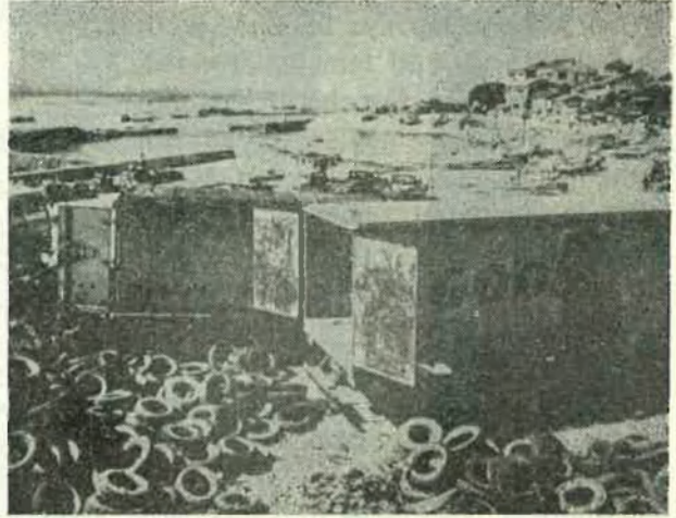
B — 20 şerlik gruplar halinde birbirlerine bağlanan eski lâstikler, Japon balıkçıları tarafından evvelce tespit edilen noktalara indiriliyor.
