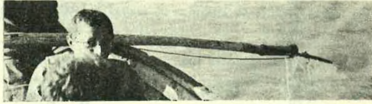
Şek. 10 Kazık, çakma kazığı ile çakılmadan önce
